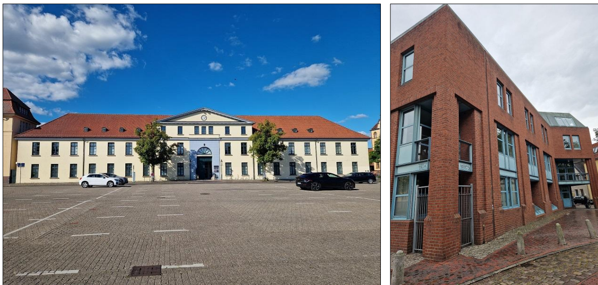
Abbildung 24 Verwaltungsgebäude Feststraße 10 [Quelle: Stadt Oldenburg]
